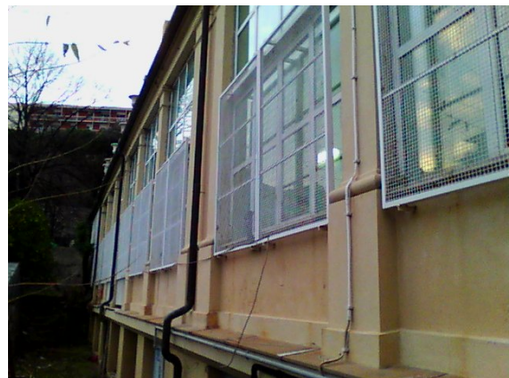
Figura 4.2 - Particolare della facciata Sud – Sud/Est
