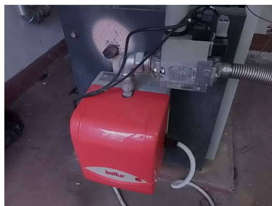
Figura 4.10 - Particolare bruciatore
