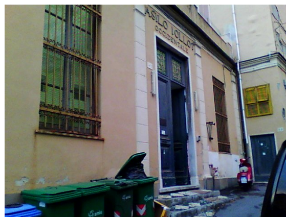
Figura 1.1 - Vista della facciata esposta a Est / Sud-Est
